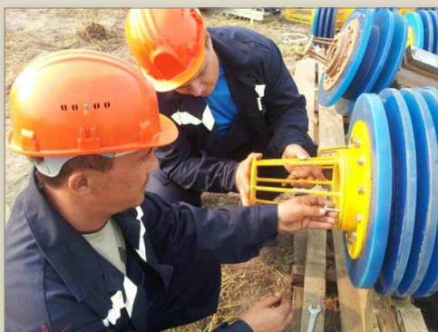
• Подготовка очистного устройства
