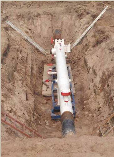
• Монтаж временных камер пуска-приема средств очистки и диагностики трубопроводов
