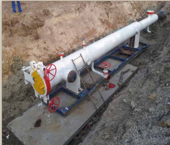
• Монтаж временных камер пуска-приема средств очистки и диагностики трубопроводов
