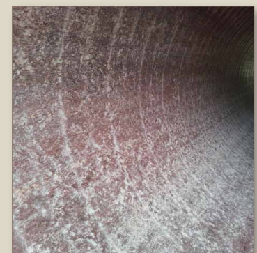
• Внутренняя поверхность трубопровода после очистки
