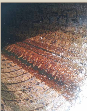
• Внутренняя поверхность трубопровода перед очисткой
