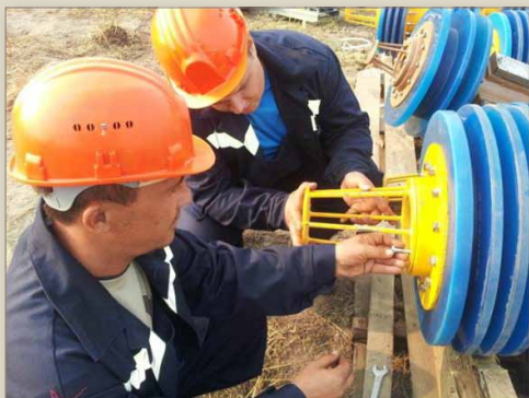
• Подготовка очистного устройства
